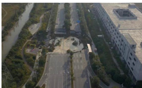
(c) 佛山轨道交通2号线隧道及路面坍塌
