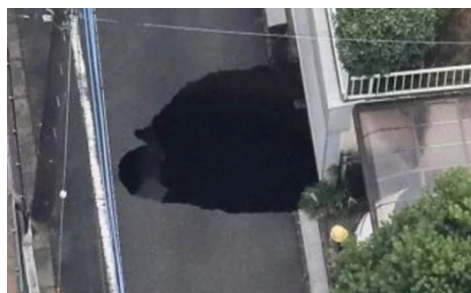
(d) 东京外环线引发路面塌陷
